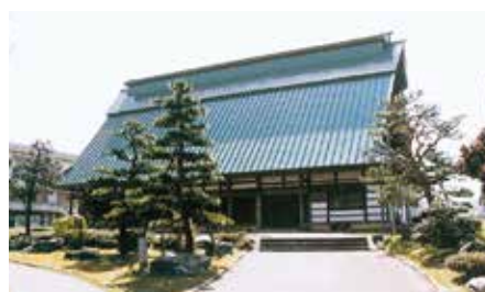
同窓会館(高啼館)
